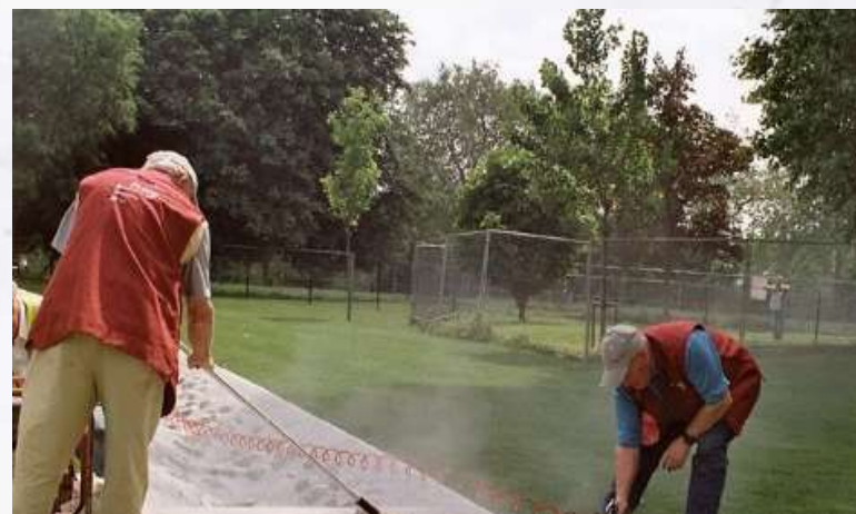
Nach der Reinigung - auftragen mit Baumwollstrip bzw. aufsprühen von Finalit Nr.20
