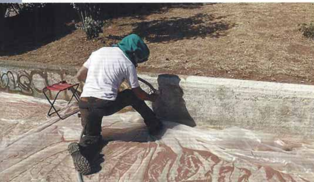
Die Oberfläche wird mit Natriumkarbonat gestrahlt und danach mit saurem Graffiti-Entferner behandelt. 30 Minuten Einwirkzeit reichen bei den meisten Flächen
