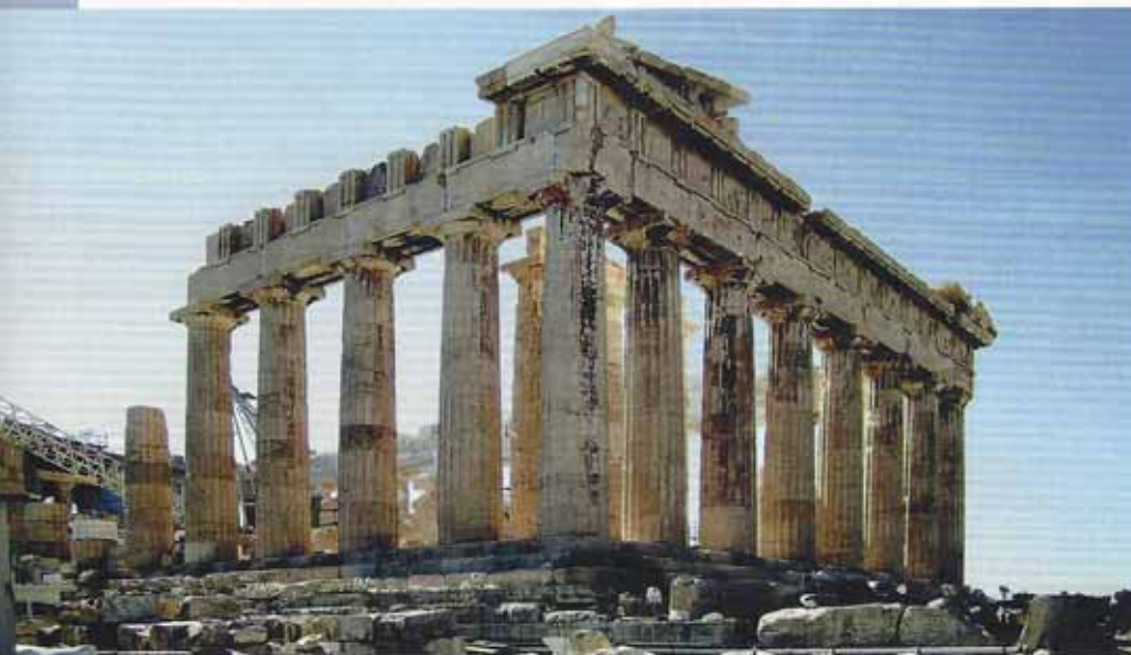
Weil die Akropolis eine archäologische Ausgrabungsstätte ist, sind Testflächen nicht möglich. Das Reinigungsteam von Finalit muss von vornherein wissen, wie es vorgeht
