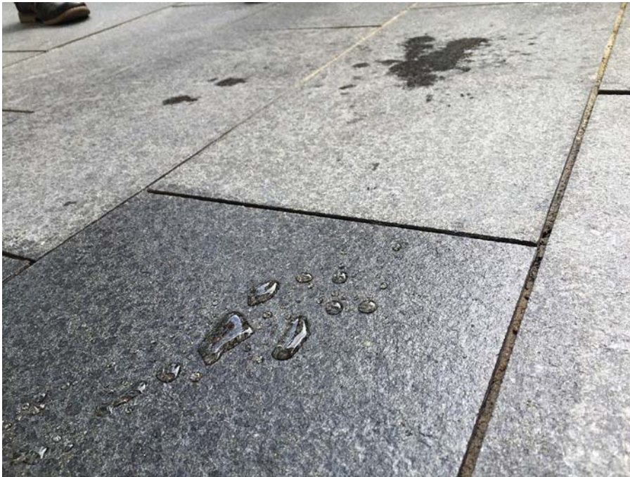
Imprägnierung mit Abperleffekt (vorn).
