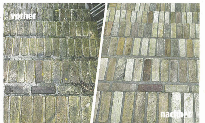
Spezialreinigung+Imprägnierung, Brasilianischer Quarzit
