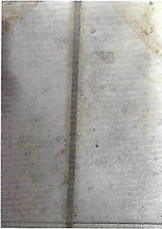
Wenn Natursteine beim Verlegen einseitiger Feuchtigkeit ausgesetzt sind, kann es zu Fugenrandverfärbungen kommen.
