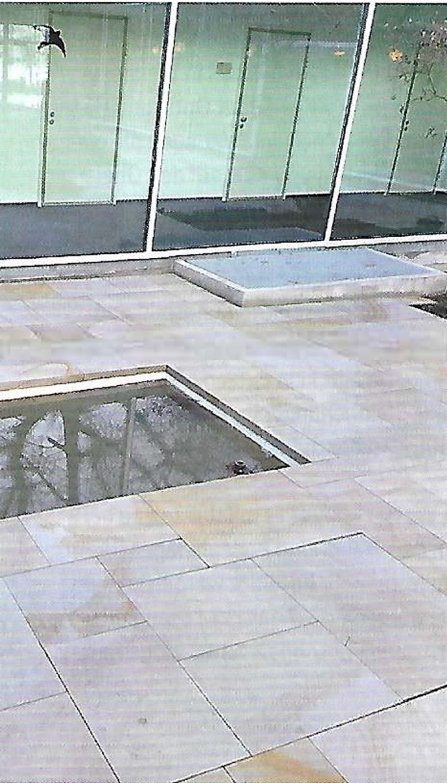
Nach der Reinigung ist die ursprüngliche Optik wieder sichtbar.
