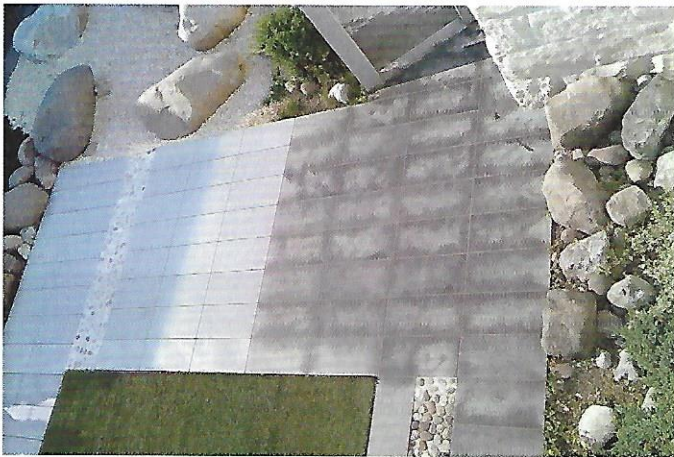
Chinesischer Granit mit und ohne Vorbehandlung mit Porenfüller
